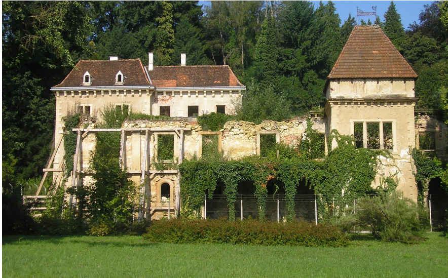
Opeka mõis enne renoveerimist, https://en.wikipedia.org/wiki/Opeka_Manor
