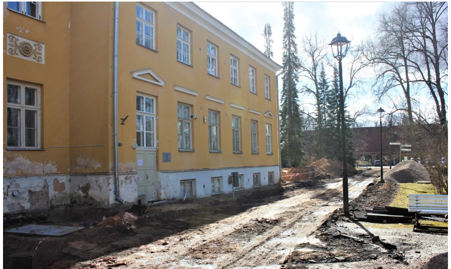
Vaade mõisa jalgteede rekonstrueerimisele lossi eest ...
