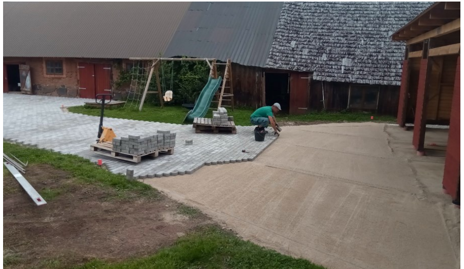
Objekt Puhjas – sõidutee sillutiskivi rajamine
